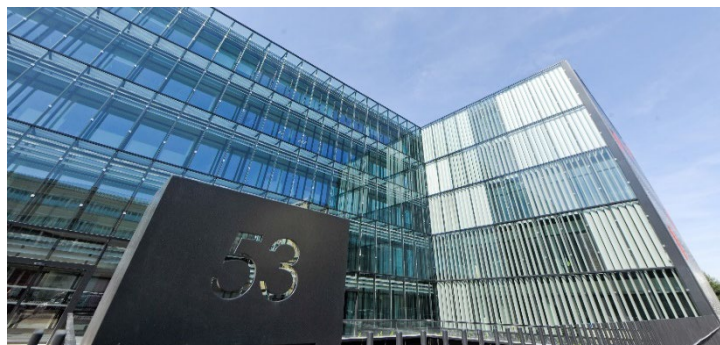
Villeurbanne (69) « Mirage » - 13 593 m 2 de bureaux
